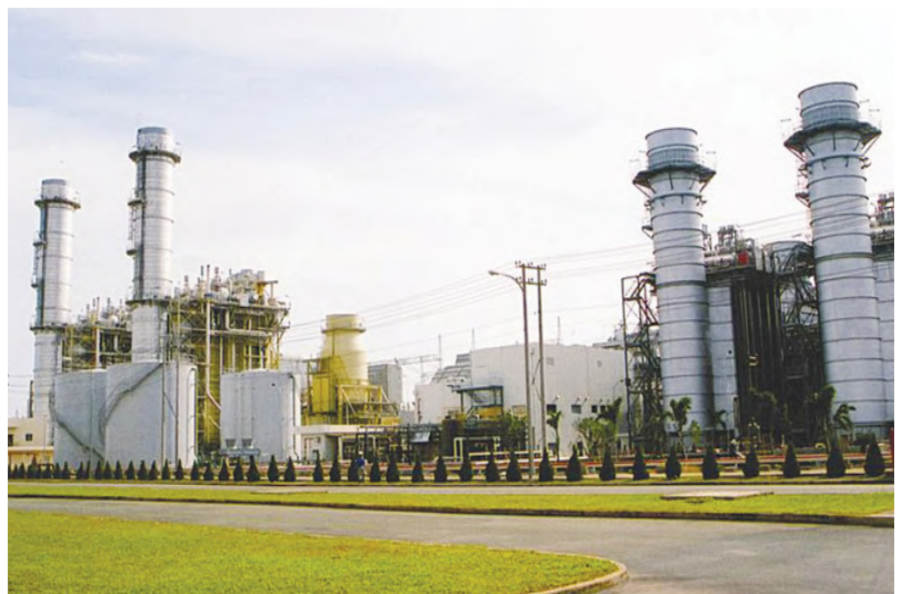
Nhà máy nhiệt điện Phú Mỹ
