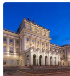
Công trình xây dựng
