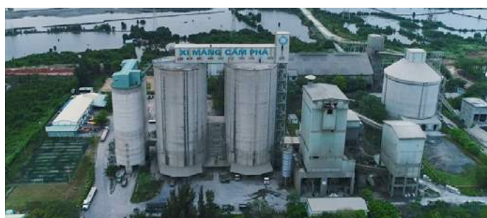
Nhà Máy Xi Măng Cẩm Phả
